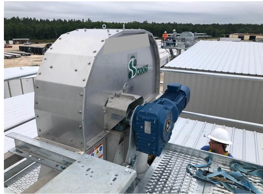
Reductor en sistema de ventilación
