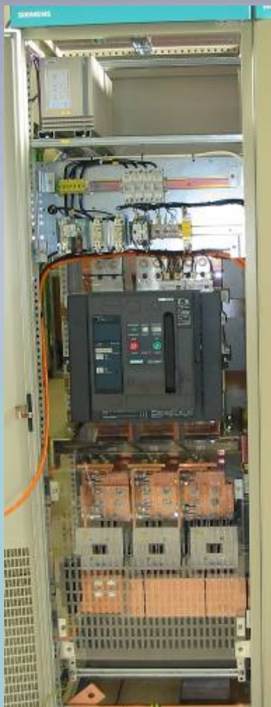
Entrada de AFE con interruptor general y contactores
