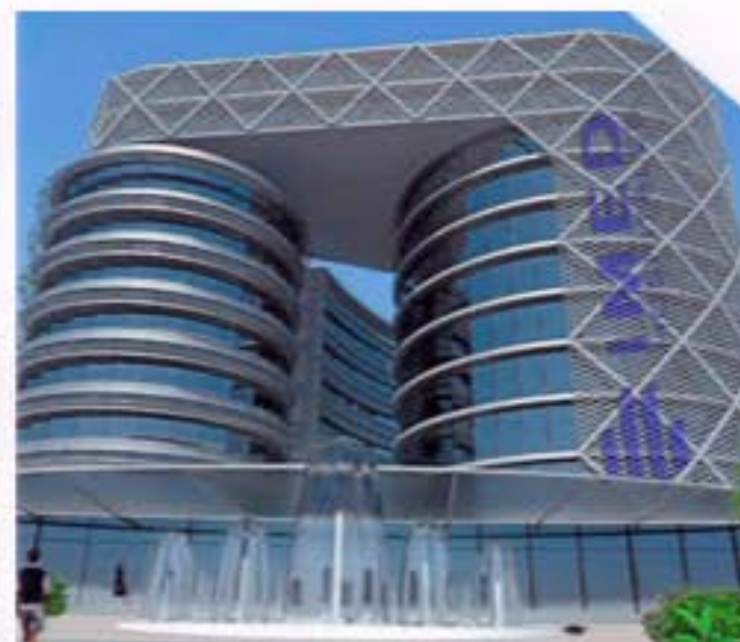
HOSPITAL IMED VALENCIA [EN PROCESO]
