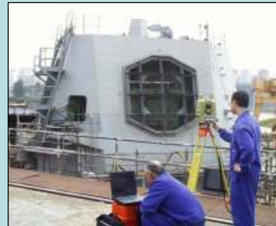
INSPECCIÓN PARA PREALINEACIÓN DEL ARO ANTENA N°2
